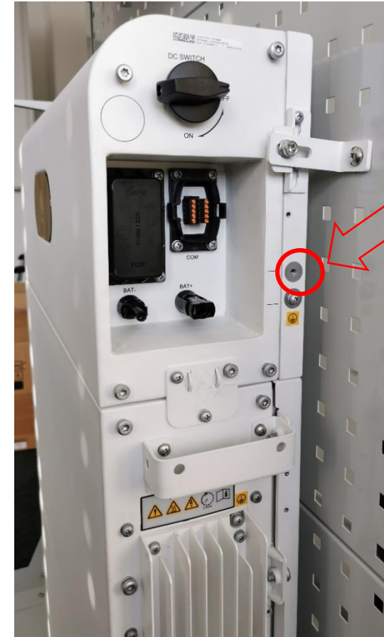
Verbindung für externe Erdung
